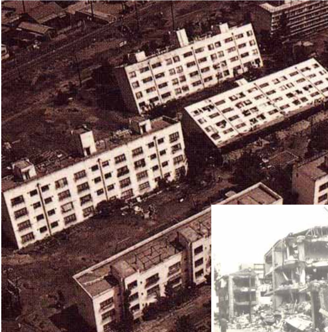
写真29 昭和39年（1964）新潟地震での傾斜した川岸町アパート（壁にひび割れもなく、窓ガラスも割れていない）（新潟日報社提供：文献1-1）
