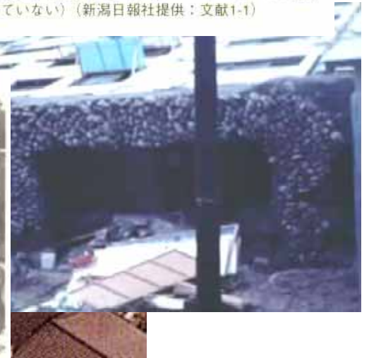
写真29 昭和39年（1964）新潟地震での傾斜した川岸町アパート（壁にひび割れもなく、窓ガラスも割れていない）（新潟日報社提供：文献1-1）
