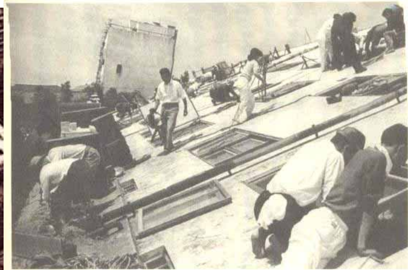
写真29 昭和39年（1964）新潟地震での傾斜した川岸町アパート（壁にひび割れもなく、窓ガラスも割れていない）（新潟日報社提供：文献1-1）
