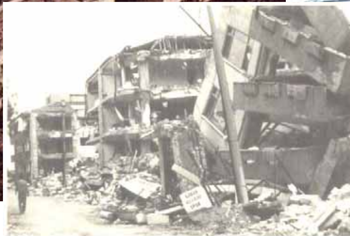
写真30 トルコのアダバサーリでの地震被害（地盤がよいところでは地震の揺れにより建物に見る影もないほどの被害）
